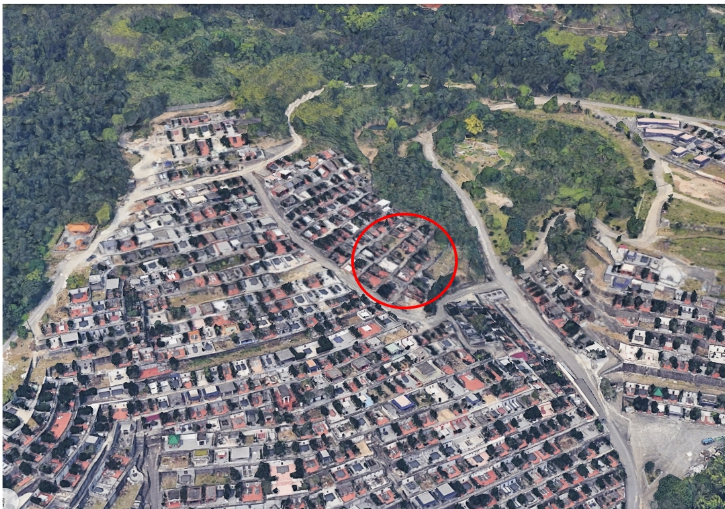
中和區橫路段 225 地號土地土石坍方處示意圖
